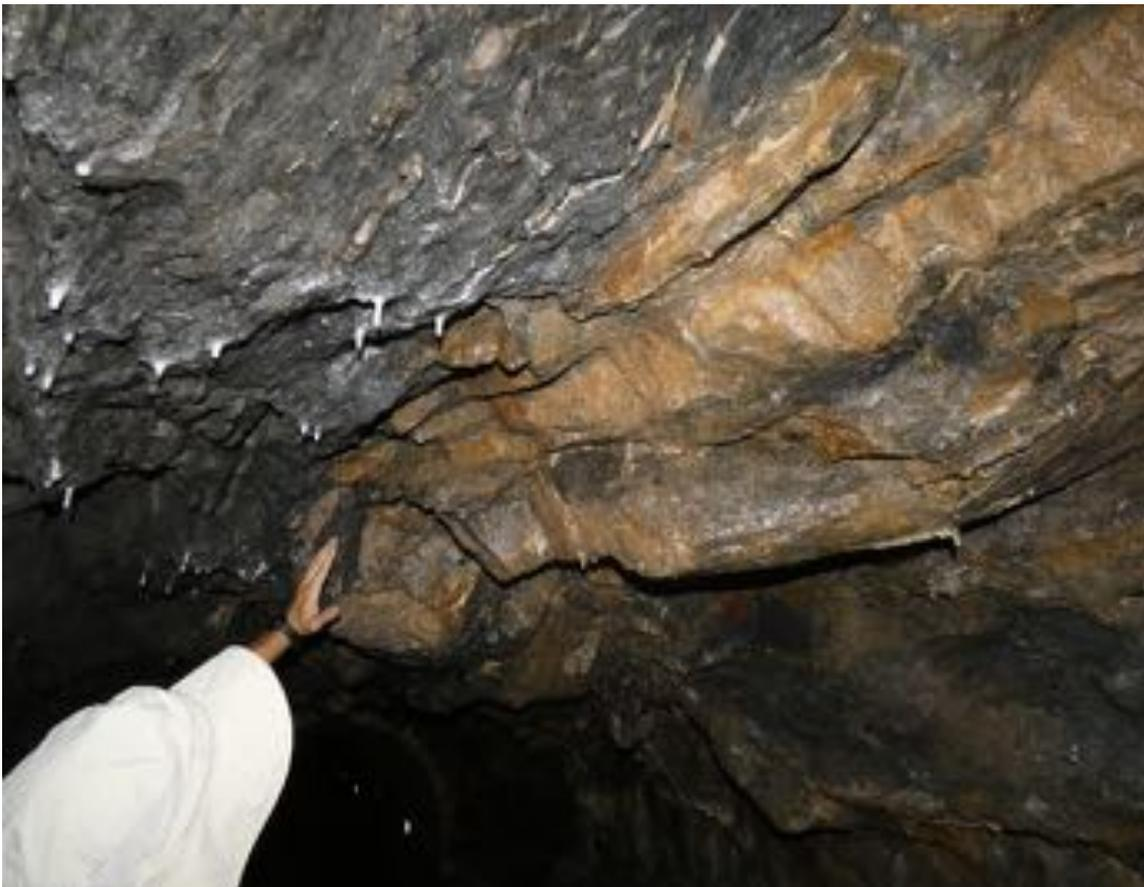
Figura 22. Disposición de las capas en Nivel 0 - Socavón a favor de la zona de falla y la dirección de la galería E-W
