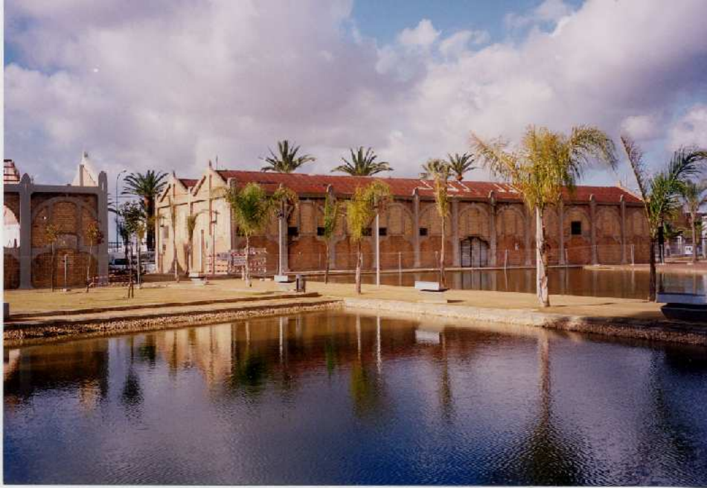
Edificios de las Cocheras de Locomotoras y Almacén General del Puerto (Foto AAPH)
