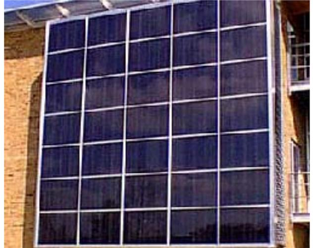
Figura 3.6 Fotovoltaicos integrados en fachada.
