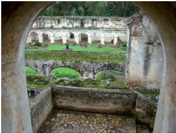
1. Guatemala. Ciudad de Antigua Guatemala. Convento de Santa Clara
